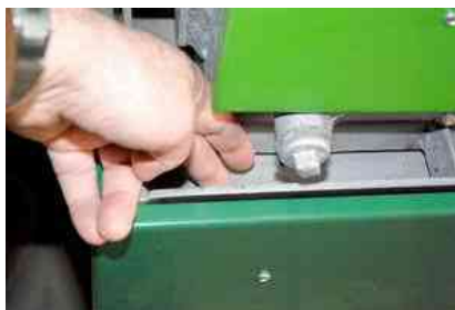
Kazántest és a salakláda közti üres hézag a malternak
