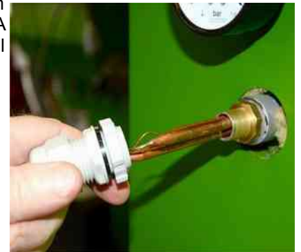
A termosztátok érzékelőinek elhelyezése. Vigyázat, törékenyek!
