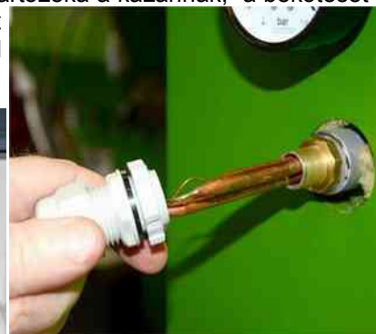
A termosztátok érzékelőinek elhelyezése. Vigyázat, törékenyek!
