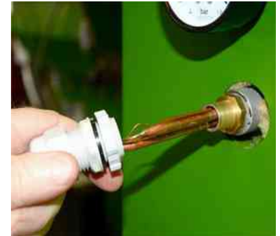
A termosztátok érzékelőinek elhelyezése. Vigyázat, törékenyek!
