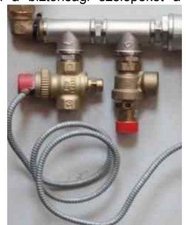
Bal oldalon a termostatikuss biztonsági szelep, jobbról a biztonsági nyomás szelep
