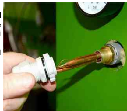
A termosztátok érzékelőinek elhelyezése. Vigyázat, törékenyek!
