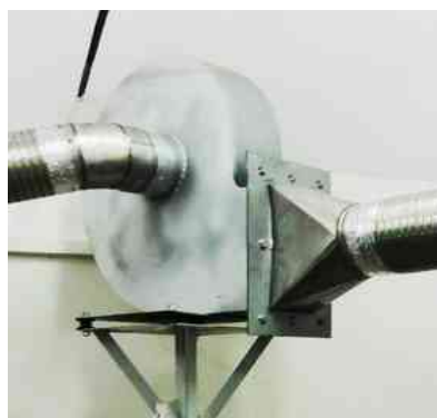
Függőleges és fordított beépítés
