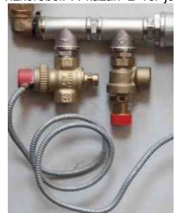
Bal oldalon a termosztatikus biztonsági szelep, jobbról a biztonsági nyomás szelep
