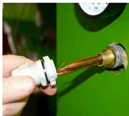
A termosztátok érzékelőinek elhelyezése. Vigyázat, törékenyek!
